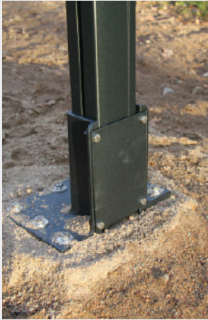
Fästplatta på gjuten plint.
